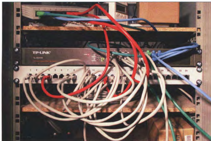
Bild 8: 19-Zoll-Technik im praktischen Einsatz; oben befindet sich der Switch und darunter das Rangierfeld (Patch-panel), über das jeder Rechner seinen eigenen Anschluss im häuslichen Netzwerk erhält.
