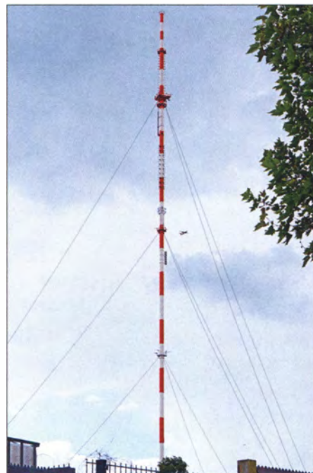
Der insgesamt 304 m hohe NDR-Sendeturm Hamburg-Moorfleet beherbergt vorrangig Antennen für UKW-Hörfunk und DVB-T
