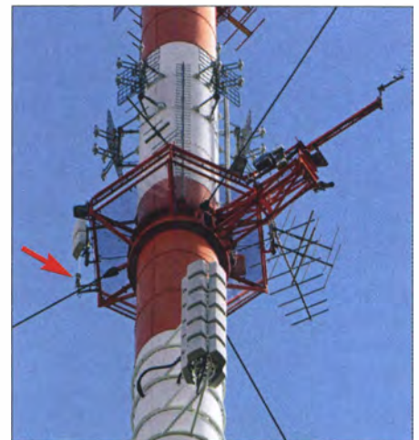
6-cm-HAMNET-Accesspoint DB0ZE in 170 m Höhe am NDR-Sendeturm Hamburg-Moorfleet Fotos: DL9DAK
